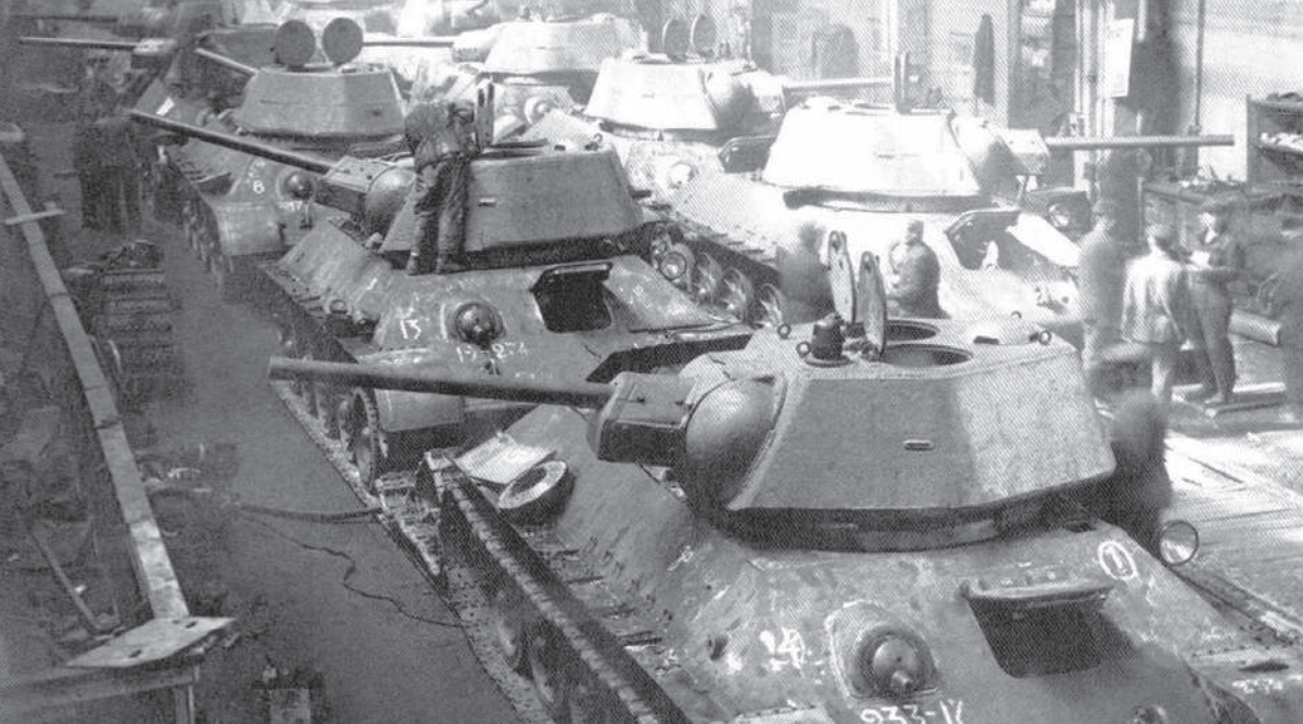
Збирання корпусів танків Т-34 із застосуванням автоматичного зварювання Євгена Патона. Нижній Тагіл. Січень 1943 року
